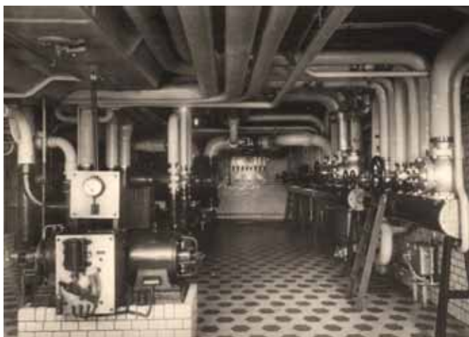
Ett av de tidigaste exemplen på pumpsystem för vattenvärmesystem är Nordiska kompaniet i Stockholm år 1913.
