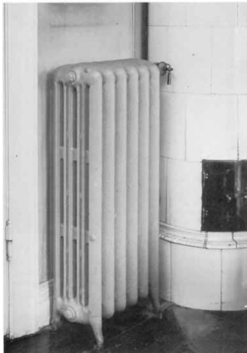
Radiatorplacering i en bostad med våningsvärmeledning från 1920. Radiatorn ersätter kakelugnen.
